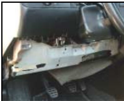
Abbau der Verkleidungen
