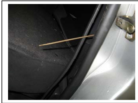
Kabelverlegung in Schwellerverkleidung links bis Fußraum Fahrer
