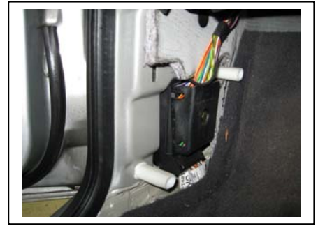
Demontage Fußraumverkleidung vorn li.
