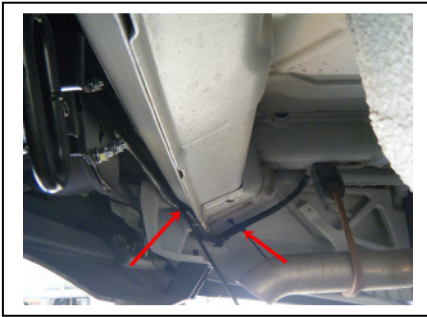
Kabelführung am Fahrzeugunterboden
