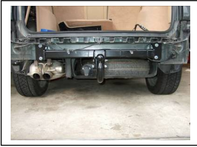
Verlegung Kabel außen
