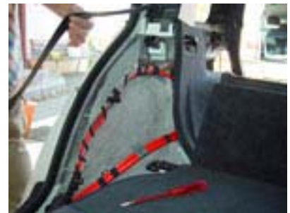
Verlegung der Kabel
