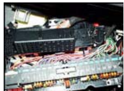
Ausbau Relaiskasten, Kammverbinder
