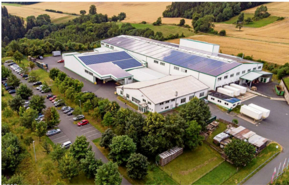
Das Firmengelände der Rameder Anhängerkupplungen und Autoteile GmbH in Munschwitz ist über die Jahre mit dem Unternehmen gewachsen. Aktuell arbeiten hier rund 120 Beschäftigte, davon etwa 40 im Lager und an der Versandstrecke.
