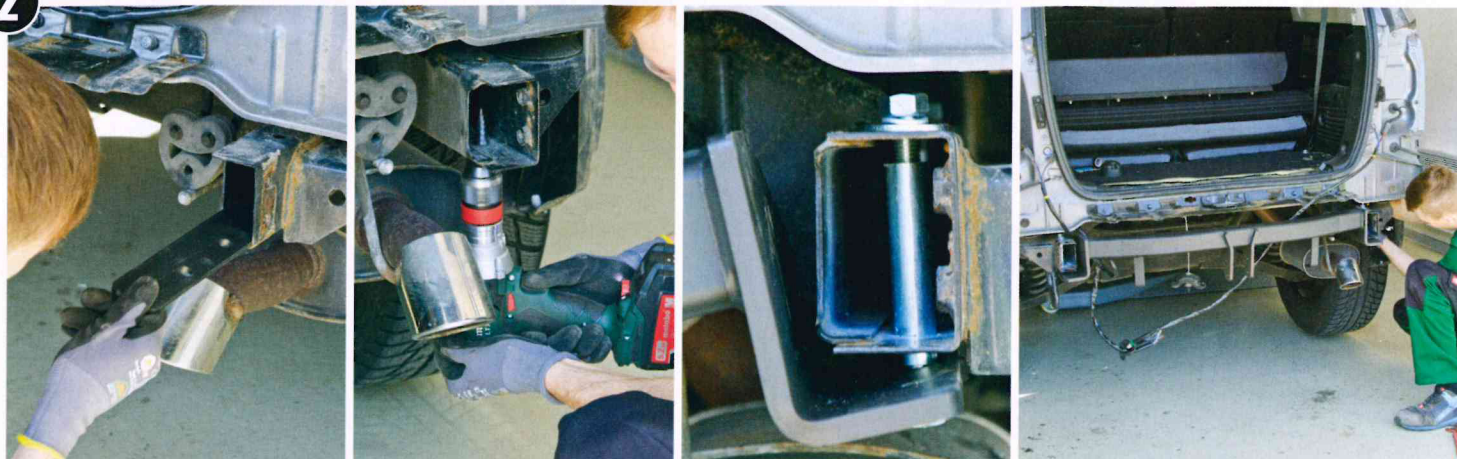
Jetzt wirds knifflig: Die Bohrungen für die Aufnahmen werden angezeichnet ... ... und die nötigen Löcher in den Rahmen gebohrt und versiegelt. Mit ein bisschen Geschick werden nun die Tüllen und der Träger ... ... am Rahmen verschraubt und mit dem richtigen Drehmoment festgezogen. Der Grundträger sitzt.
