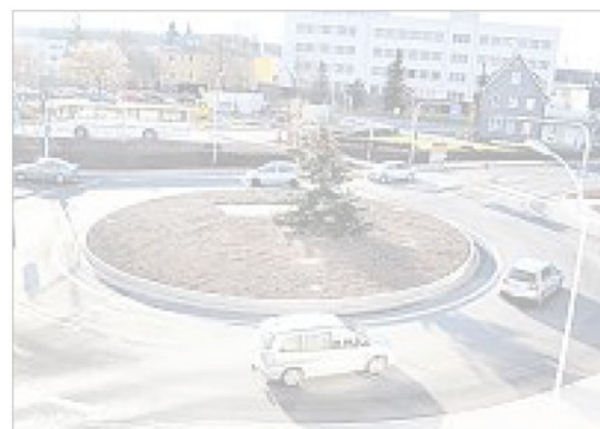
Der fertig gestellte Kreisverkehr. Foto: Norbert Kleinteich
