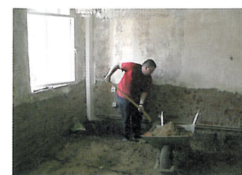
Im Erdgeschoss wurde der Boden und der Putz entfernt ...
