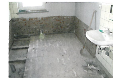
Beim zweiten Arbeitseinsatz wurden unter anderem im Bad die Bodenfliesen, der Holzboden, die Wanne sowie der Putz entfernt.
