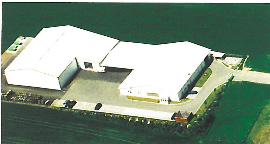
Die neue Versandzentrale in Munschwitz. Rechts das Bürogebäude, Mitte und links Versand und Lager.
